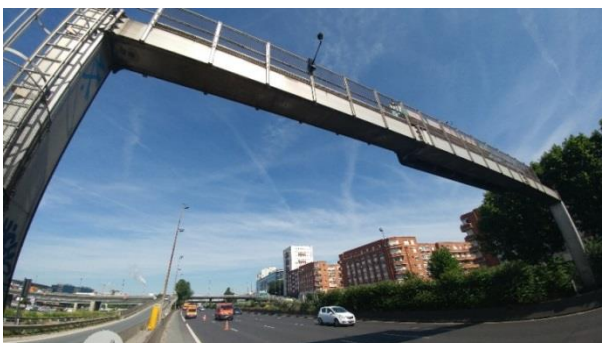
Emplacement d'une station de mesure de surveillance du bruit (A4) à Joinville-le-Pont (94)
